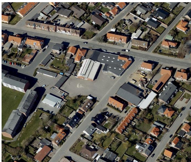
Skråfoto af lokalplanområdet fra syd med bygninger tilhørende tidligere erhvervsvirksomhed. Foto optaget d. 17. april 2019.
